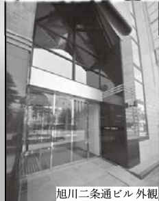
旭川二条通ビル 外観
