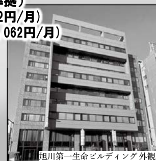
旭川第一生命ビルディング 外観
