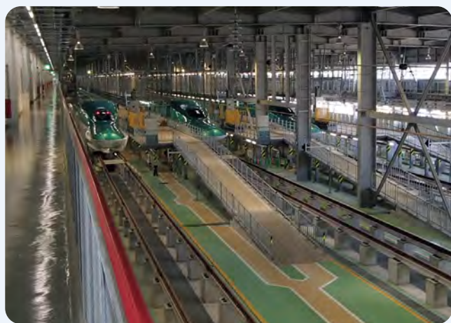
▲施工例～北海道新幹線車輛基地(仕様交番庫)
