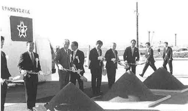
▲工事の安全を祈願しくわ入れを行う参加者
