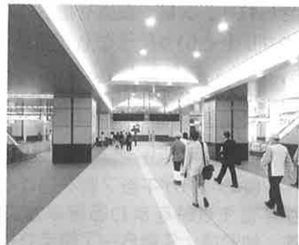
工事中の新青森駅舎内
