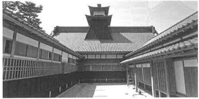
▲中庭から望む太鼓櫓(屋根最高部)。当時は太鼓櫓から時間を知らせる太鼓がたたかれていました。オープン後は、安全面の配慮から一般開放はしない予定となっています。
