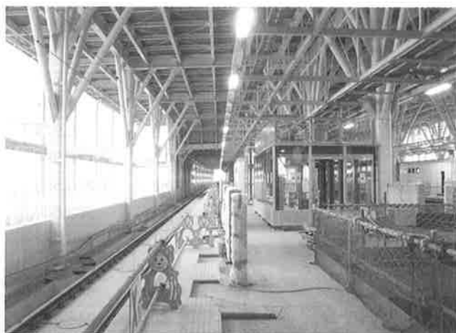
▲工事が進む新青森駅
