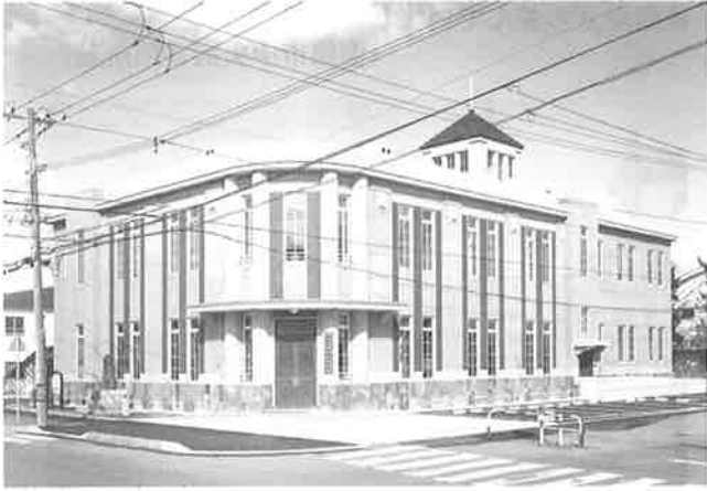
▲整備後の函館市臨海研究所
