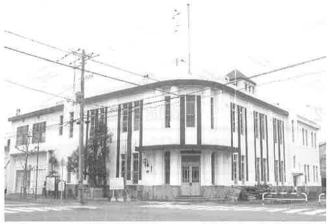
▲整備前の同施設
