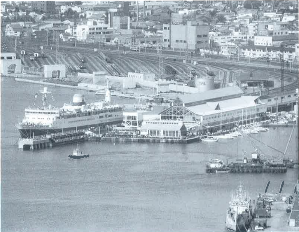
函館シーボートプラザ（旧青函連絡船棧橋）
