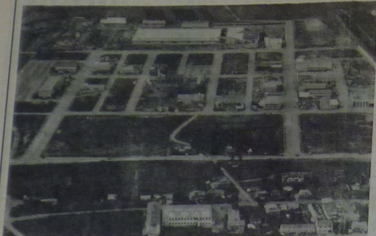
上空から見た卸センターの全景 (西栲栳町)
